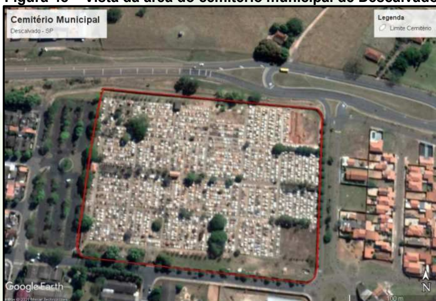
Figura 48 – Vista da área do cemitério municipal de Descalvado.
