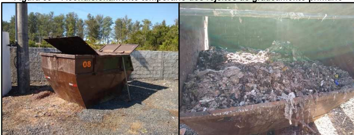
Figura 39 – Acondicionamento temporário dos rejeitos do gradeamento primário
