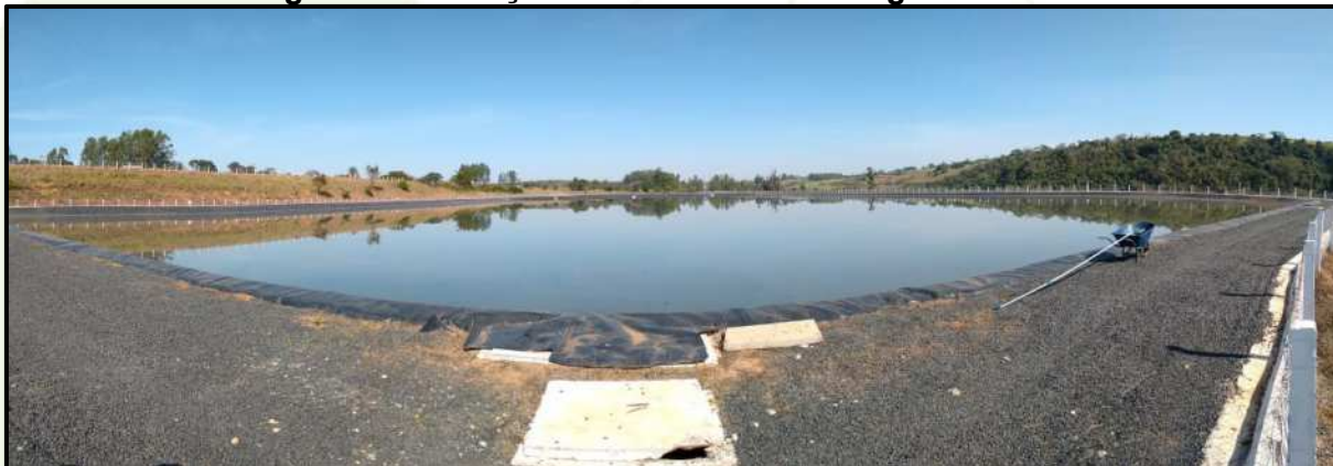
Figura 38 – Estação de Tratamento de Esgoto de Descalvado
