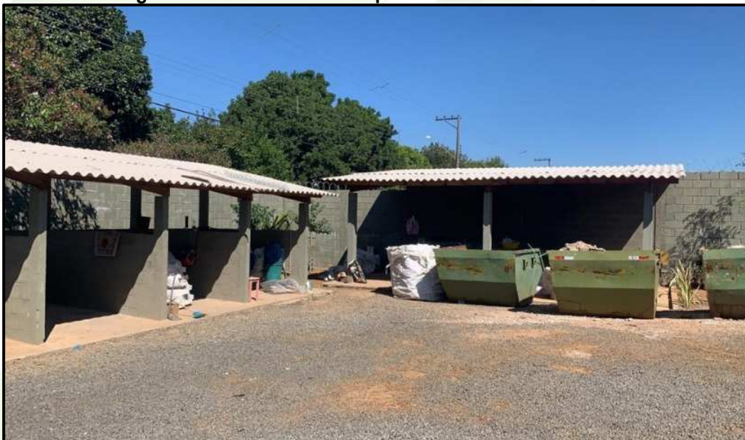
Figura 9 – Área coberta: Ecoponto de São Carlos.
