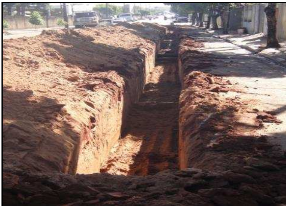
Figura 99 - Rede coletora em implantação na Av. Bom Jesus.
