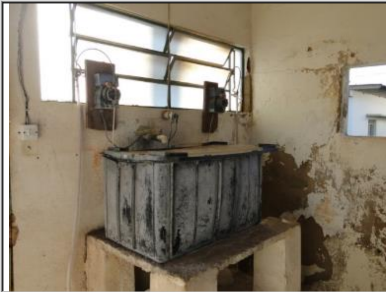
Figura 46 - Dosador de ácido fluossilícico
