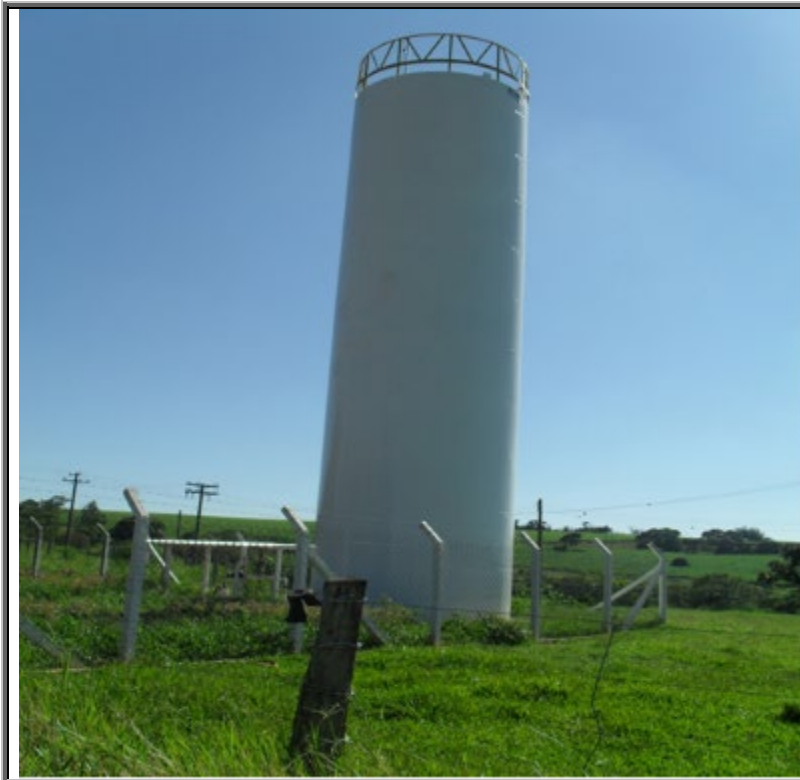
Figura 56 - Reservatório Recanto do Cisne I
