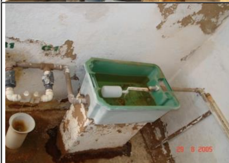
Figura 45 - Dosador de hipoclorito de sódio
