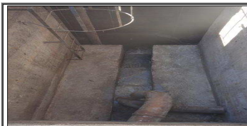
Figura 108 - Gradeamento - Estrutura implantada na estação elevatória de esgotos-1.
