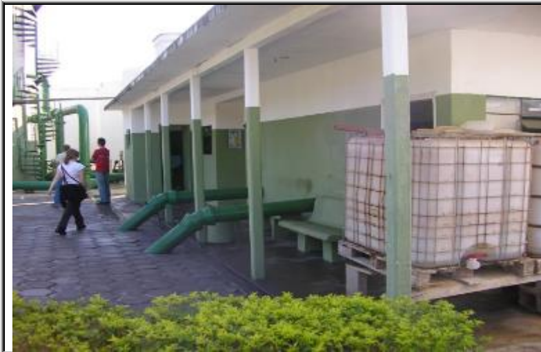
Figura 28 - Vista frontal da ETA
