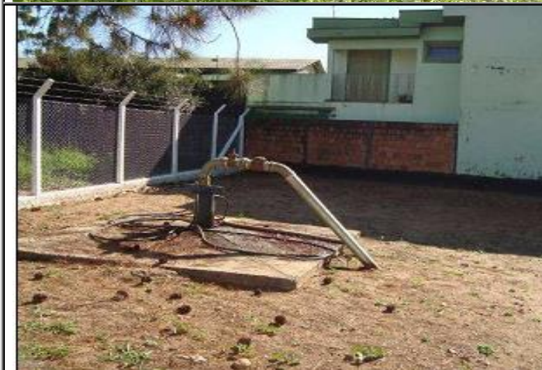
Figura 90 - Poço tubular com área limpa circunvizinha ao poço - Jardim Belém.
