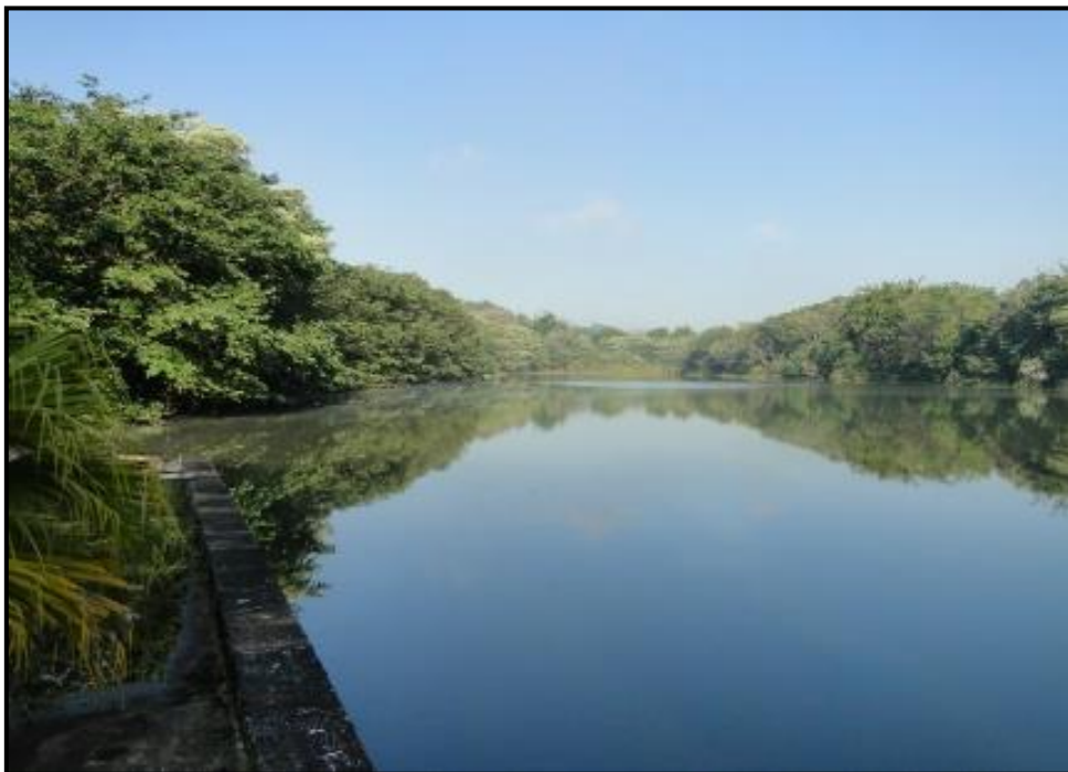
Figura 26 - Vista do lago da Represa Calmon.
