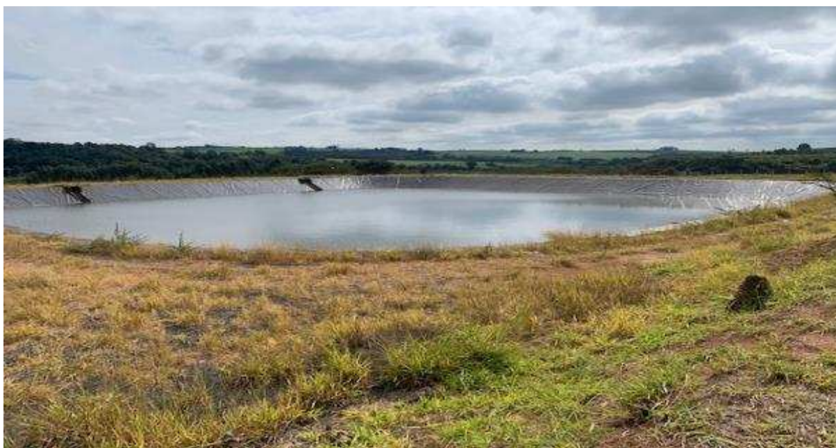
Figura 130 - Lagoa facultativa em fase de teste de impermeabilização
