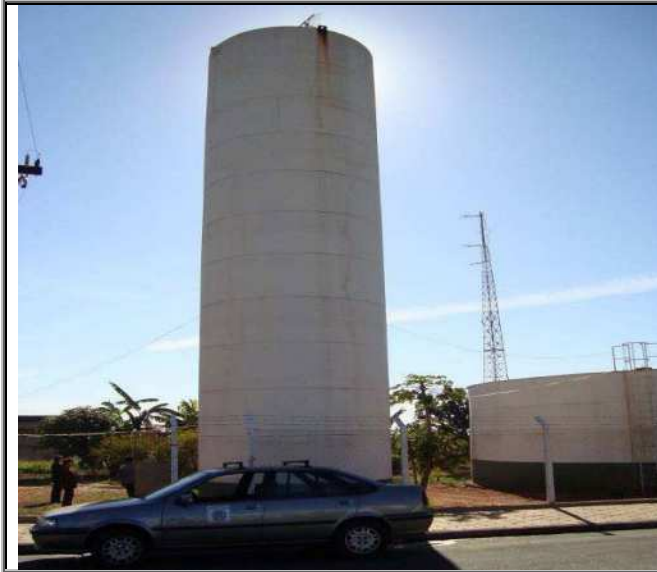
Figura 62 - Reservatório Apoiado/Elevado (160 m 3 )
