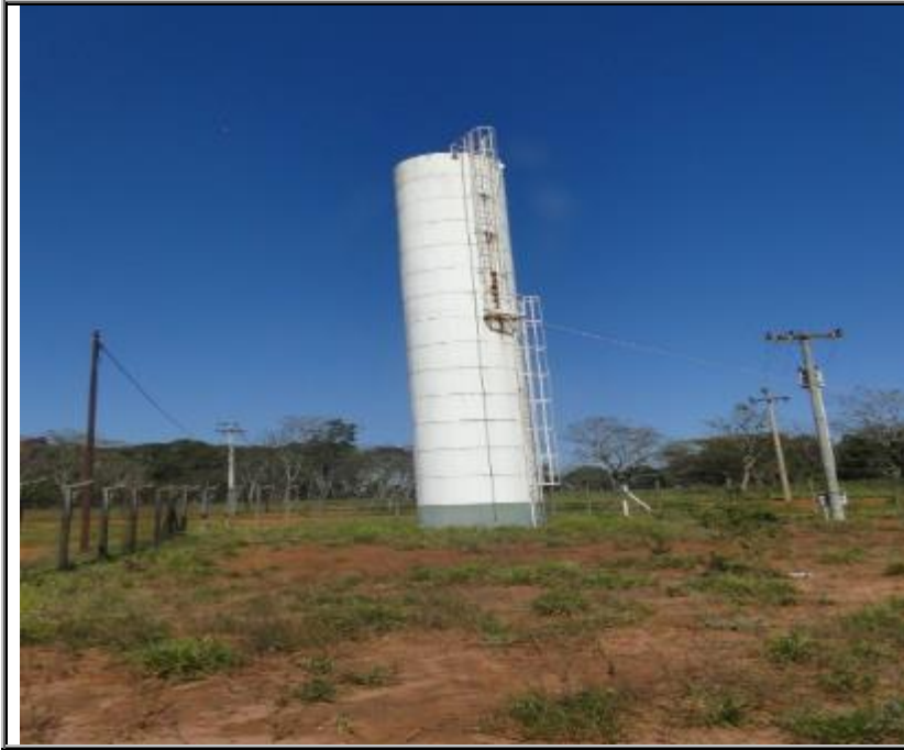
Figura 96 - Reser- vatório Apoiado- Elevado
