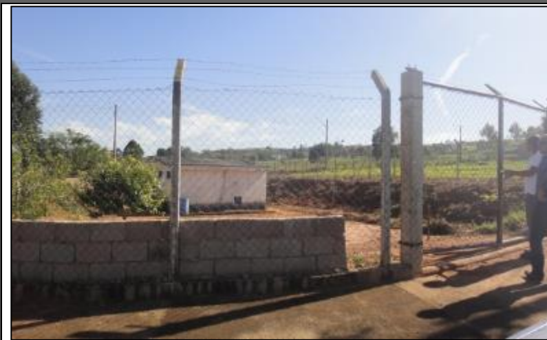
Figura 106 - Portão de acesso - Estação elevatória de esgoto-1
