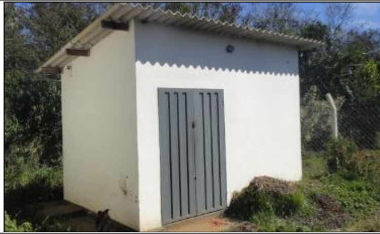
Figura 115 - Prédio 1 da EEE1 - EEE Final
