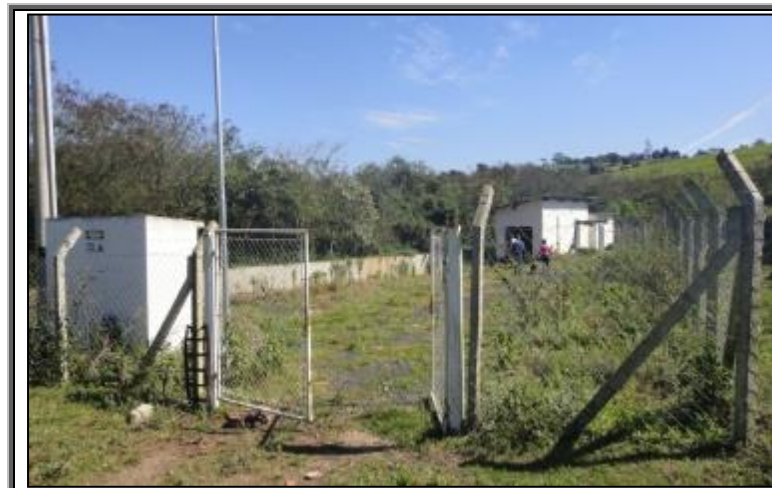
Figura 114 - Portão de acesso – EEE Final
