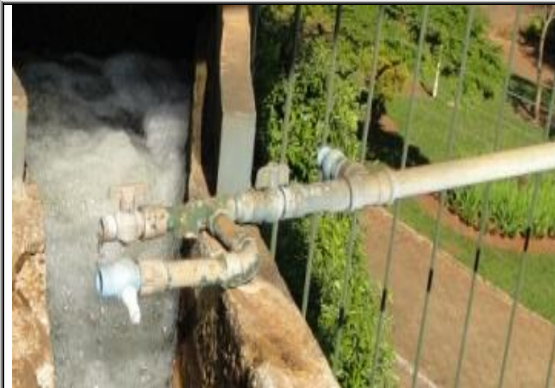
Figura 31 - Ponto de aplicação do coagulante
