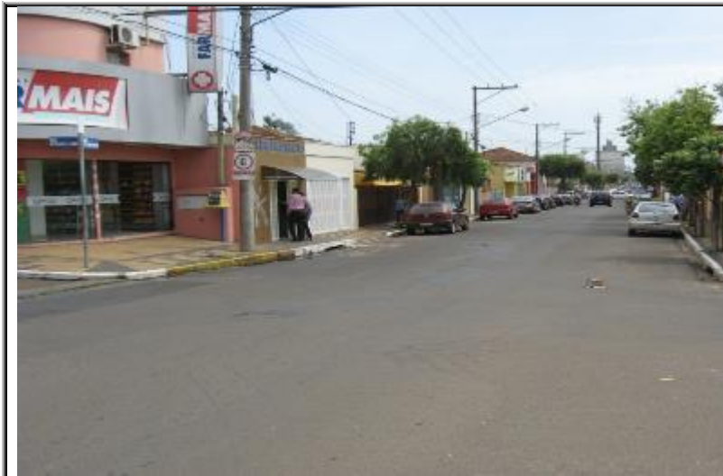
Figura 151 - - Vista da Rua Coronel Artur Whitacker, local passível de alagamentos.
