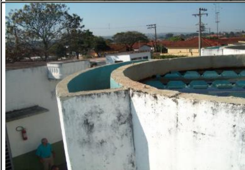
Figura 39 - -Detalhe do coletor de água filtrada
