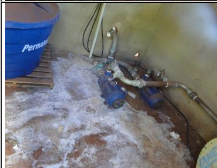
Figura 75 - Casa de química e bombas
