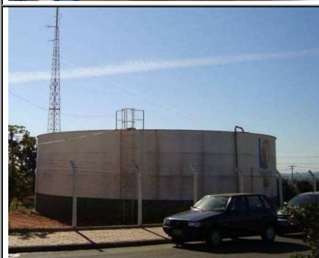
Figura 61 - Reservatório Apoiado (1.000 m 3 )
