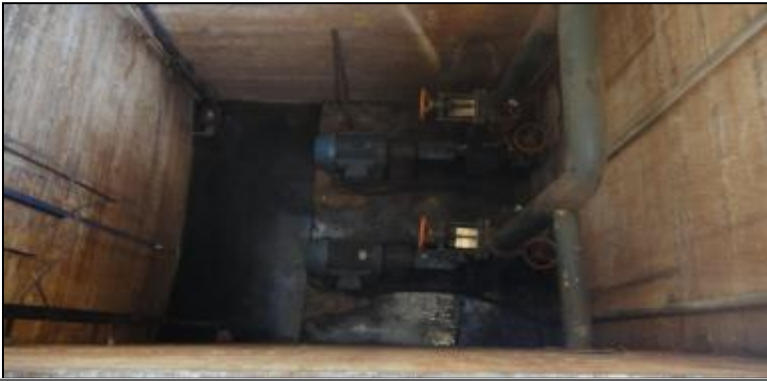
Figura 110 - Sala de bombas Estrutura implantada na estação elevatória de esgotos- 1.
