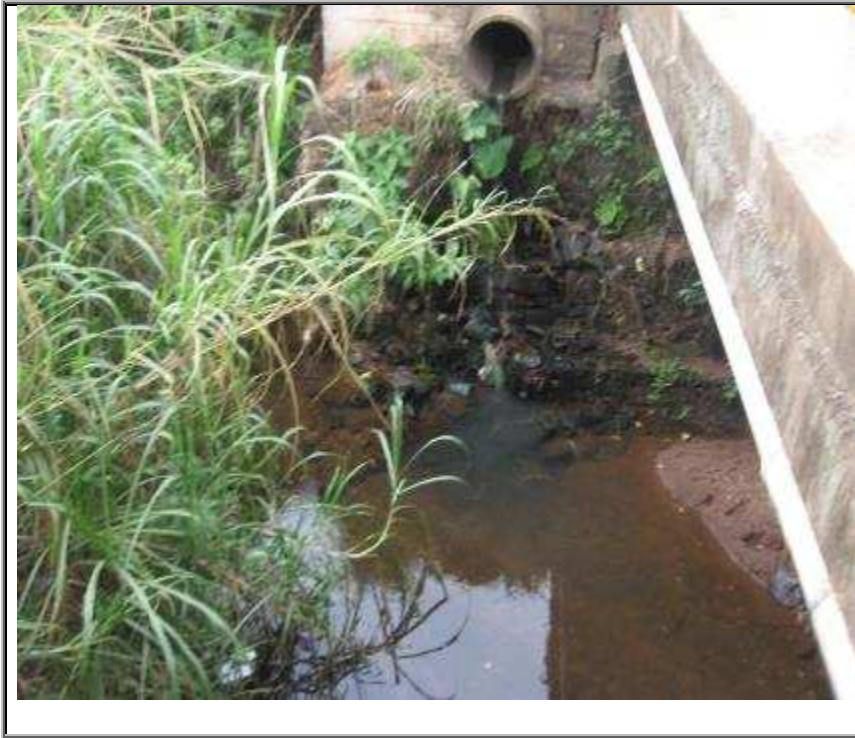
Figura 177 - Vista a montante da Travessia Padre Jeremias Nogueira.
