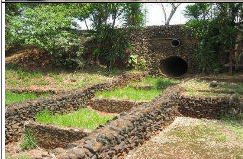
Figura 184 - Dissipador de Energia a jusante da Rua Artur Whitacker. A estrutura encontra-se em boas condições estruturais.
