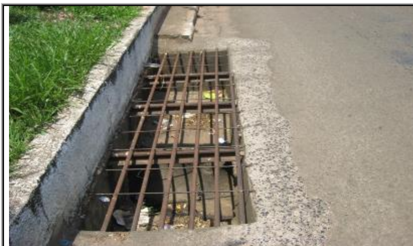
Figura 183 - Boca de lobo tripla localizada na Rua Artur Whitacker, no Bairro Jardim do Lago.
