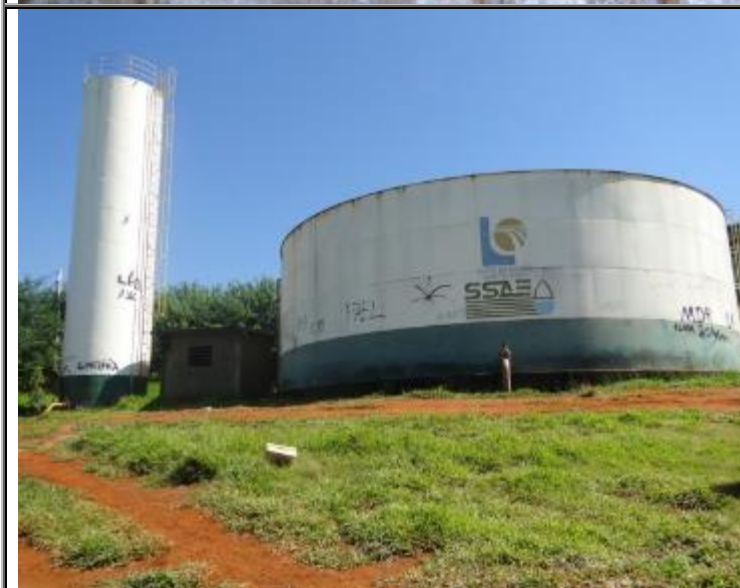
Figura 77 - Reservatórios Apoiado (1.000 m 3 ) e Apoiado/Elevado (100 m 3 )
