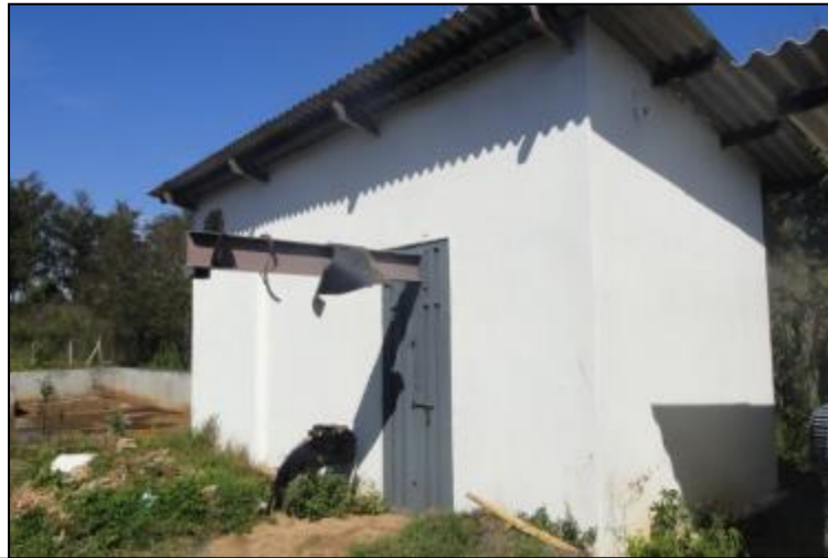
Figura 116 - Prédio 2 da EEE1 - EEE Final
