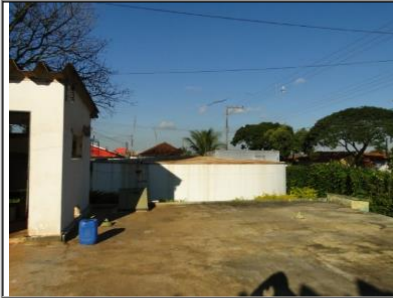
Figura 52 - Tanque de armazenamento de água de lavagem de filtros, para reuso direto na entrada da calha Pashal
