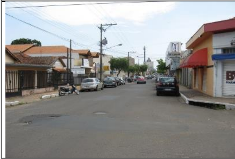
Figura 157 - Vista da Rua Artur Whitacker, trecho passível de alagamentos.
