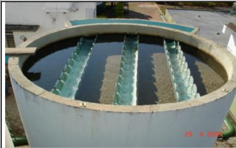
Figura 37 - Vista aérea de um filtro
