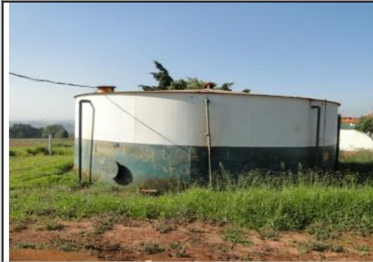
Figura 71 - Reservatório Apoiado (170 m 3 )
