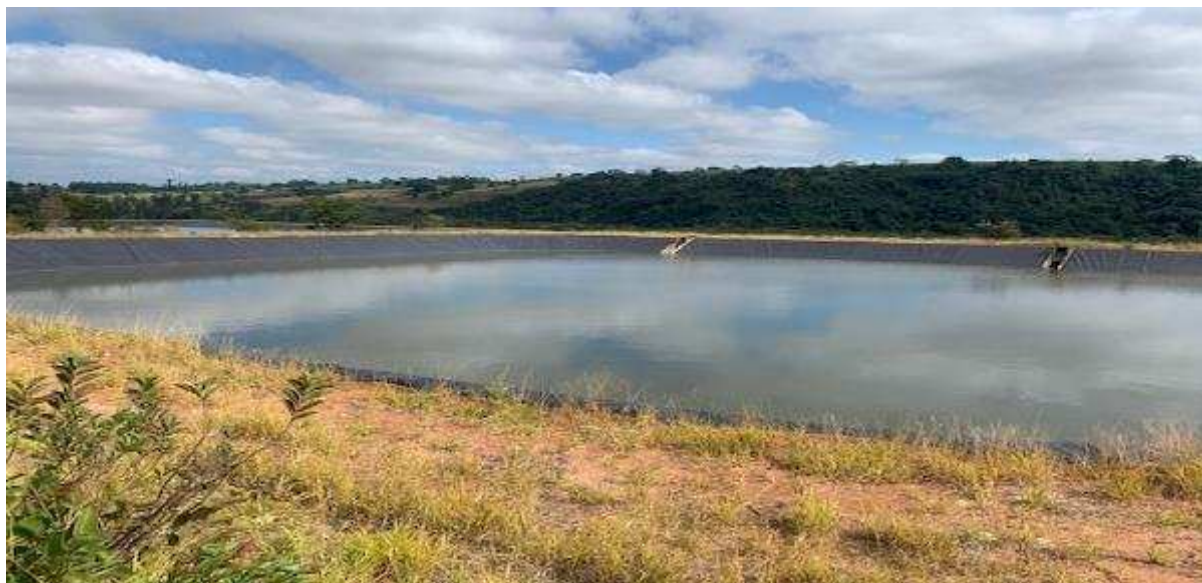
Figura 129 - Lagoa aeróbica em fase de teste de impermeabilização
