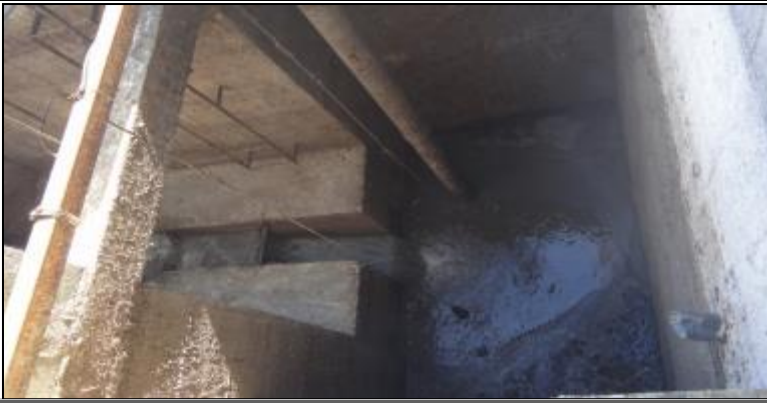
Figura 109 - Poço de sucção Estrutura implantada na estação elevatória de esgotos- 1.
