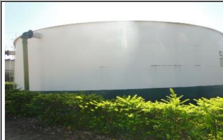
Figura 49 - Reservatório apoiado
